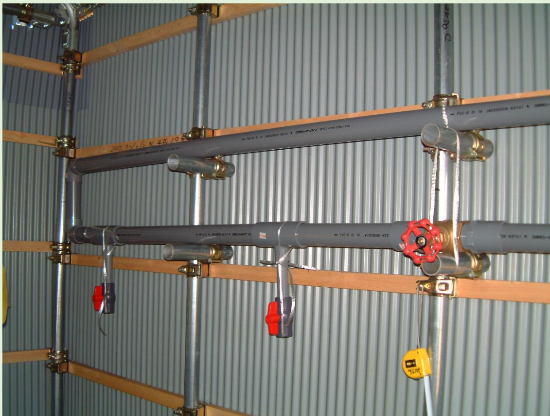
メインループ配管（施工中）
